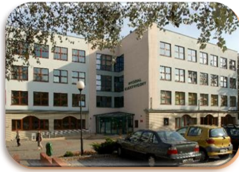
Budynek WE przy ul. 26 Kwietnia 10
